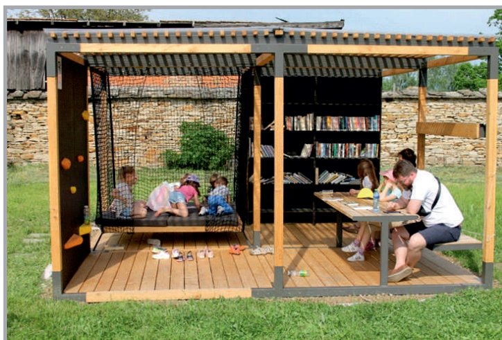
Foto: Multifunkční pergola pořízená v rámci projektu a umístěná v areálu klášterní zahrady
